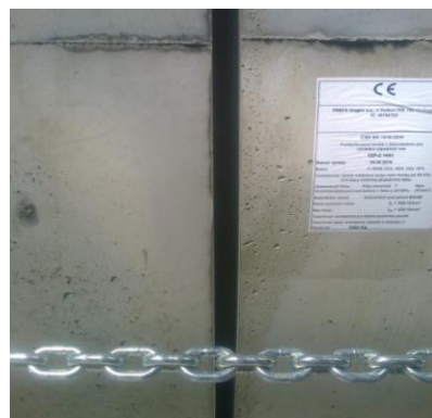
Obrázek č. 4 – Detail po stažení – vnější spára
