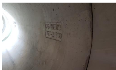
Obrázek č. 6 – Detail vnitřní spáry po spojení trub
