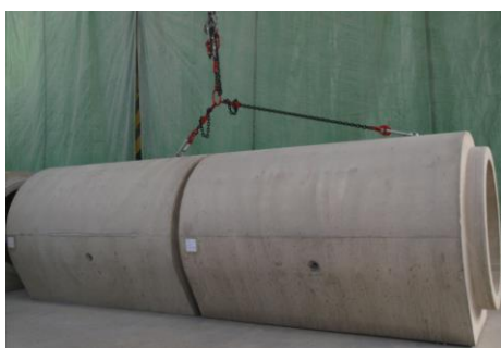
Obrázek č. 8 – Spojování trub pomocí řetězového ukladače
