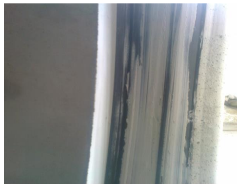
Obrázek č. 2 – Polodrážka, integrované těsnění-klužný prostředek DS Gleitmittel fy DS Dichtungstechnik
