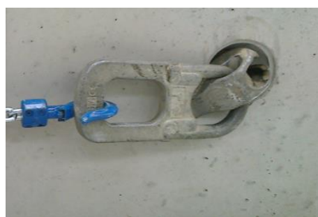
Obrázek č. 5 – Detail uložení pákového zvedáku RZC s článkovým řetězem na jedné straně trouby
