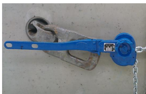
Obrázek č. 5 – Detail uložení pákového zvedáku RZC s článkovým řetězem na jedné straně trouby
