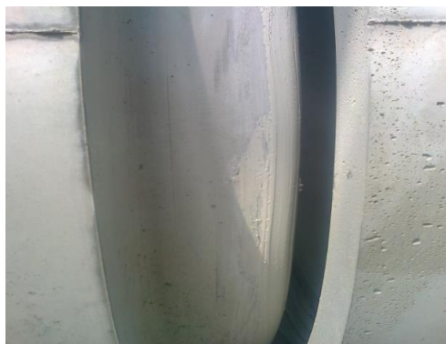
Obrázek č. 2 – Polodrážka, integrované těsnění-klužný prostředek DS Gleitmittel fy DS Dichtungstechnik
