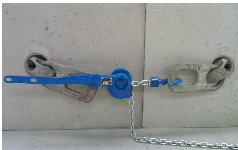
Obr. 7 Detail vnější a vnitřní spáry finálního spojení rámových propustí.
