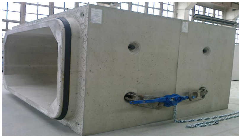
Obr. 6 Ukázka sestavy řehtačkového zvedáku po dokončení spojení obou prvků. Výrobky jsou staženy na sraz.
