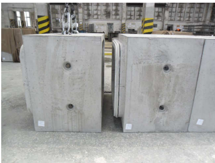
Obr. 1 Uložení propustí na rovném betonovém podkladu a provedení aplikace kluzného prostředku na těsnění a do hrdla propusti
