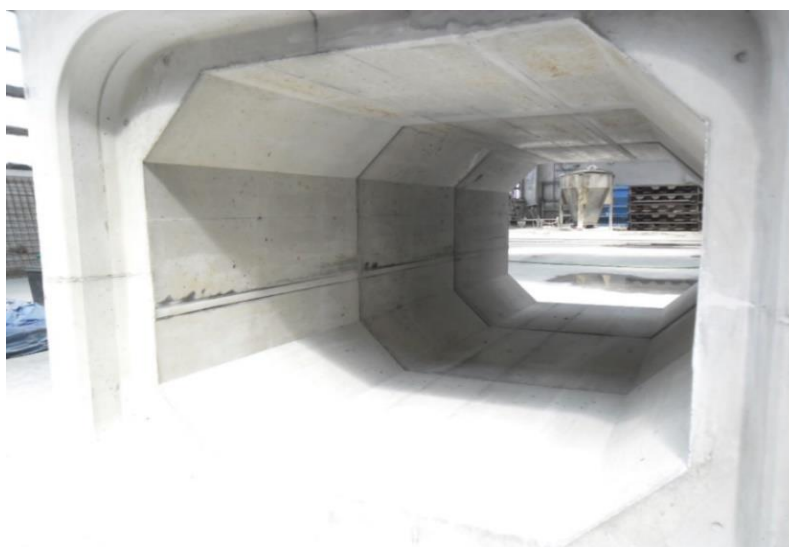
Obr. 8 Pohled do vnitřní části rámových propustí.
