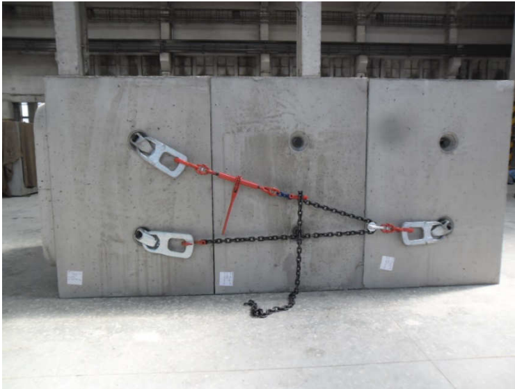
Obr. 8 Finální spojení rámových propustí. Následně se ráčnový napínák povolí (vyšroubuje) a rámové propusti zůstávají spojené.
