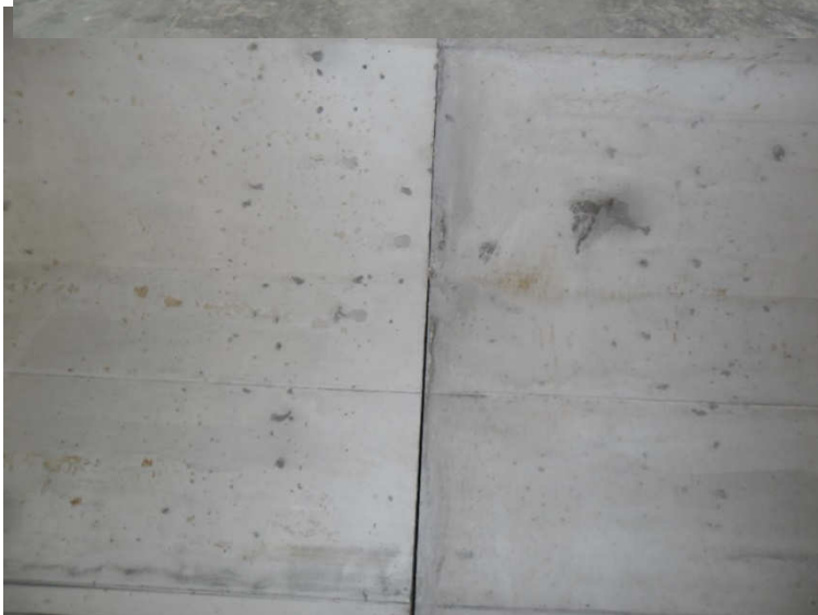
Obr. 10. Detail vnitřní spáry finálního spojení rámových propustí. Výrobky jsou staženy na sraz.
