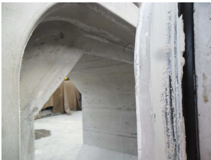
Obr. 2 Detail aplikace kluzného prostředku DS Gleitmittel na těsnění a na vnitřní část hrdla rámové propusti
