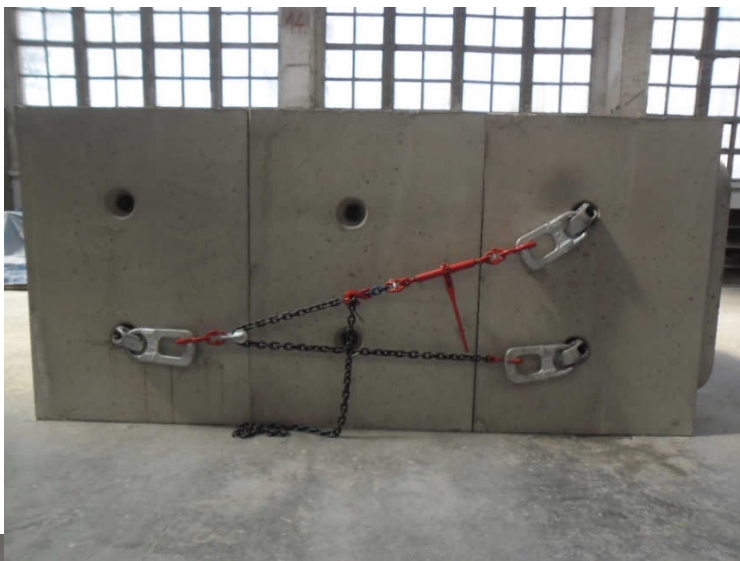
Obr. 9 Finální spojení rámových propustí – druhá strana.
