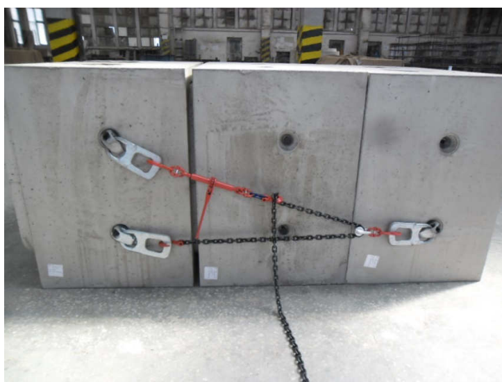
Obr. 6 Ukázka napnutého řetězového spojovače se zašroubovaným ráčnovým napínákem. Následně se napínák povolí (vyšroubuje), napnou se oka řetězu a stažení se opakuje.
