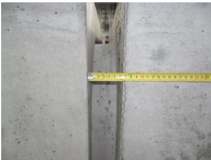
Obr. 3 Základní spára před začátkem spojování. Toto spojení docílíme ručním zatlačením rámových propustí do sebe při zavěšení propustí na jeřábu.
