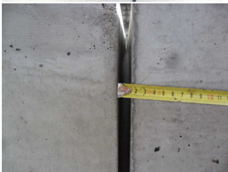
Obr. 7 Vnější spára po druhém stažení řetězovým spojovačem. Stažení o cca 2 cm.
